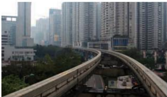
重庆大有公司防腐整治重庆第一条轻轨线（2号线）
